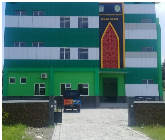
Gambar 2.6 Gedung Baru Ma’had Darul Muta’alimin Sumber. Olahan Peneliti
