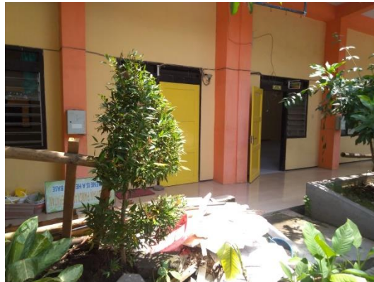
Gambar 4.1 Ruang laboratorium di bongkar
