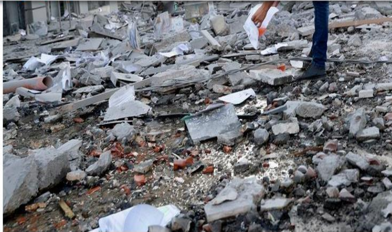
Seorang pria mengais puing-puing gedung klinik perawatan kesehatan Gaza, yang hancur diserang Israel dari udara pada Senin (17/5/2021). (AP PHOTO/ADEL HANA)
