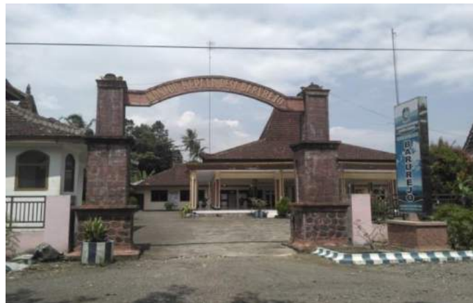
Gambar 4.1 Kantor Desa Barurejo Kecamatan Siliragung Kabupaten Banyuwangi
