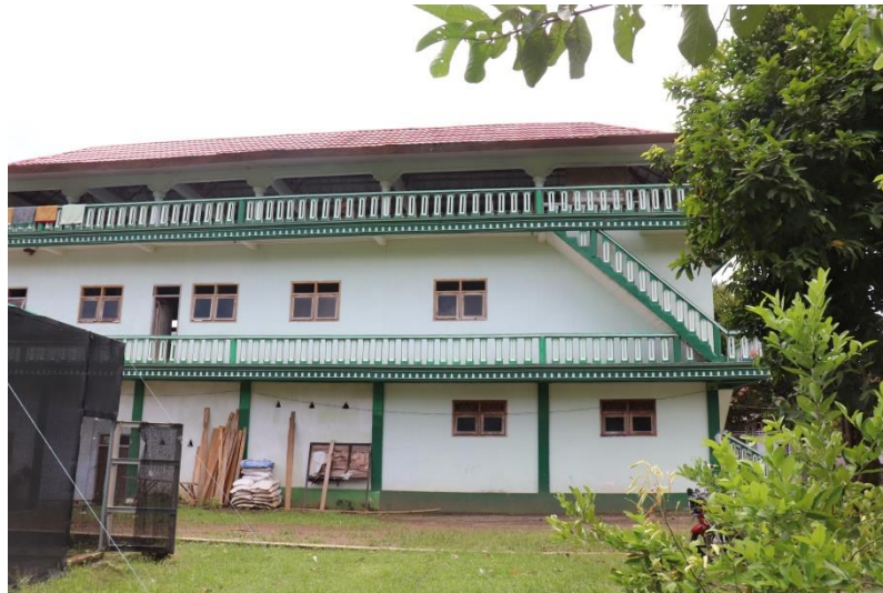
Keadaan gedung diSMK Mamba'ul Huda Sumberurip, 2021
